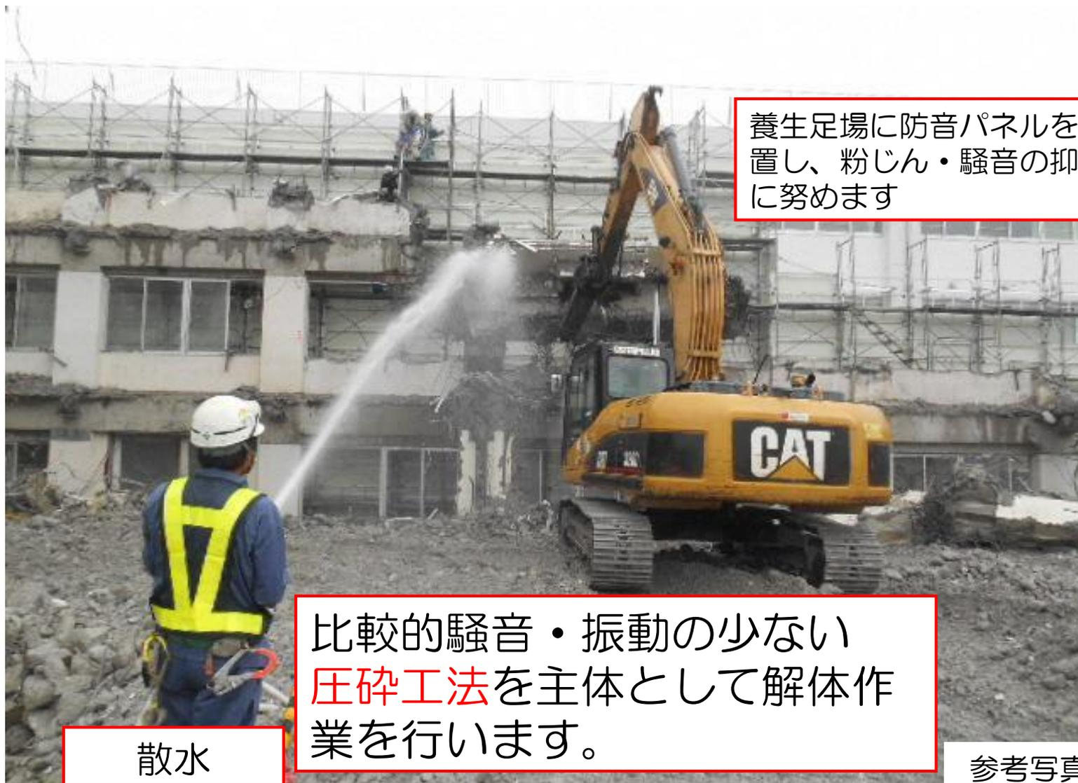
養生足場に防音パネルを設置し、粉じん・騒音の抑制に努めます
