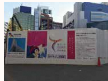
池袋西口公園 工事仮囲い
